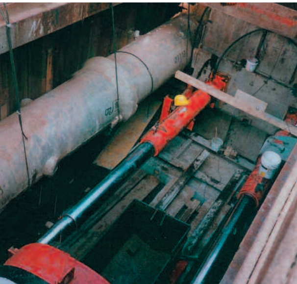
Startbaugrube mit Presseinrichtung und Vortriebsrohr (im Bild unten), links der aufgehängte Altkanal
