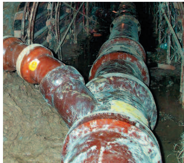
Tunnel mit Kanal und Hausanschluss
