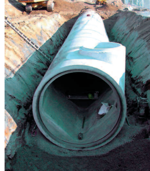
Kanalbaugrube im freien Gelände, geböscht
