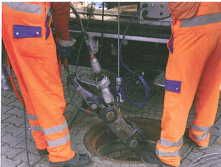
Bild 1: Einsetzen der Kamera in den Schacht
