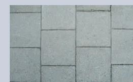
Pflaster mit dichten Fugen
