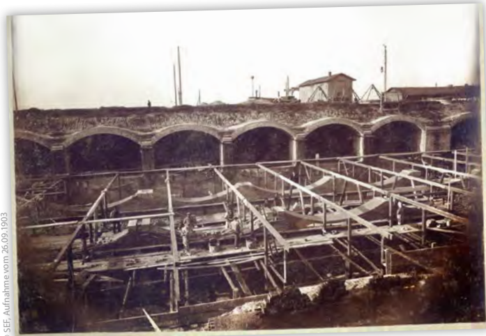
Bild 3: Umbau und die Erweiterung der Klärbecken: Aufmauern der Gegengurfen, im Hintergrund die ursprünglichen Gewölbe der Anlage
