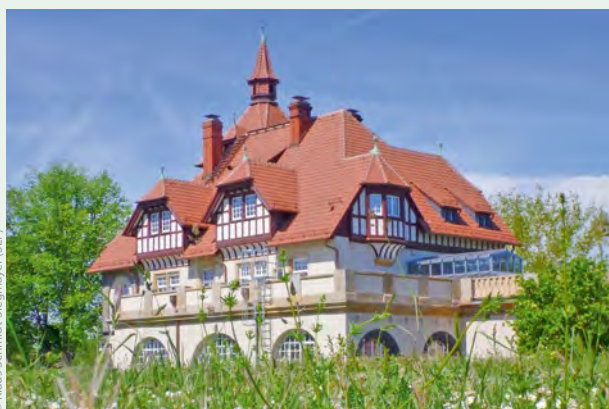
Bild 1: Das sanierte gründerzeitliche Betriebsgebäude ist Denkmal 2017
