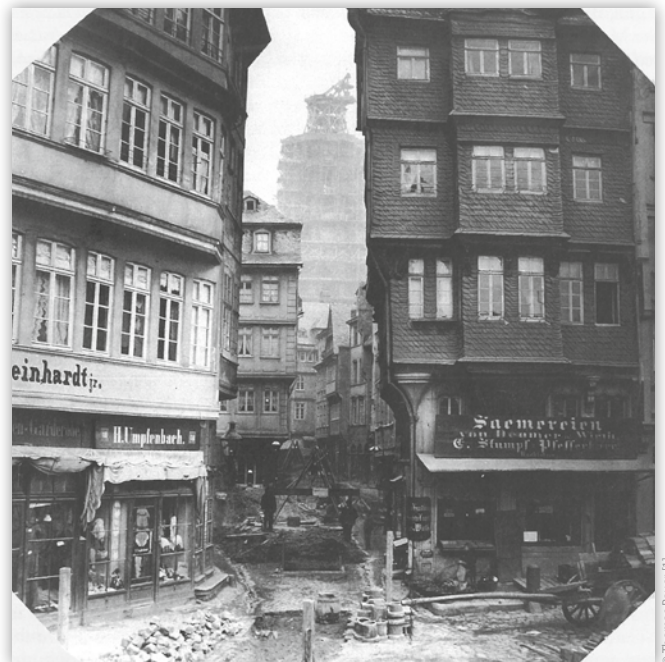
Bild 2: Kanalbau im Alten Markt um 1870. Im Hintergrund der eingeringüstete Domturm
